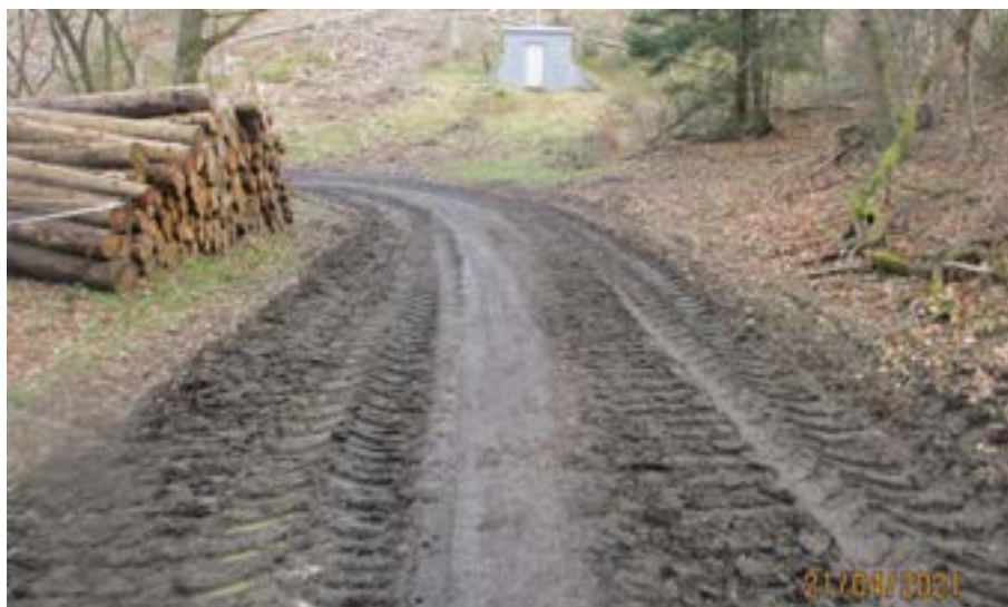
Abbildung 99: Beispiel einer Radwegeverbindung, die nach Forstarbeiten nur noch eingeschränkt nutzbar ist (eigenes Foto (VAR+, 2021))
