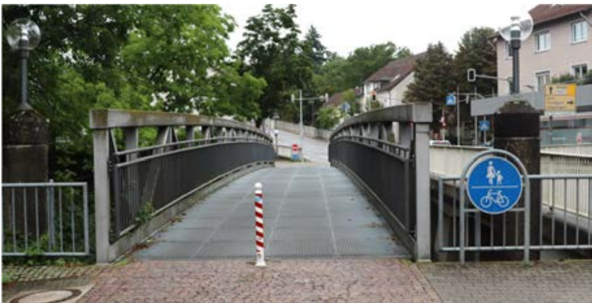
Abbildung g2: Faurndau - Filsbrücke vom Hirschplatz parallel zur K 1410 Bismarckstraße (Quelle (VAR+, 2021))
